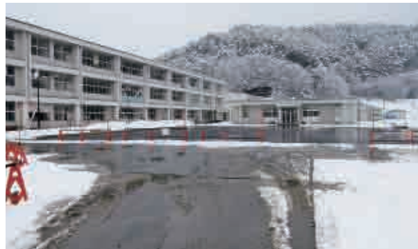
改修工事完成間近
